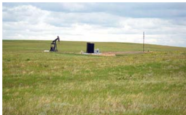
Förderanlage der erworbenen Ölquelle in Claresholm
