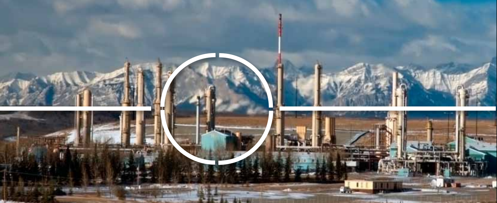
Gasreinigungsanlage, in der schwefelhaltiges Erdgas vom Schwefel getrennt und dann weitergeleitet wird.
